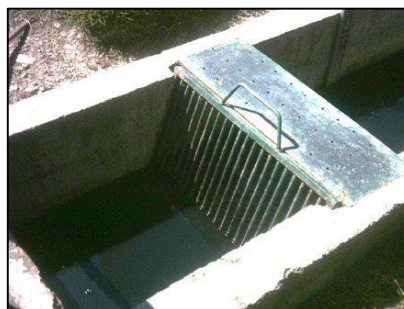
Figura 13. Rejilla de desbaste manual, (Autor, 2015)
