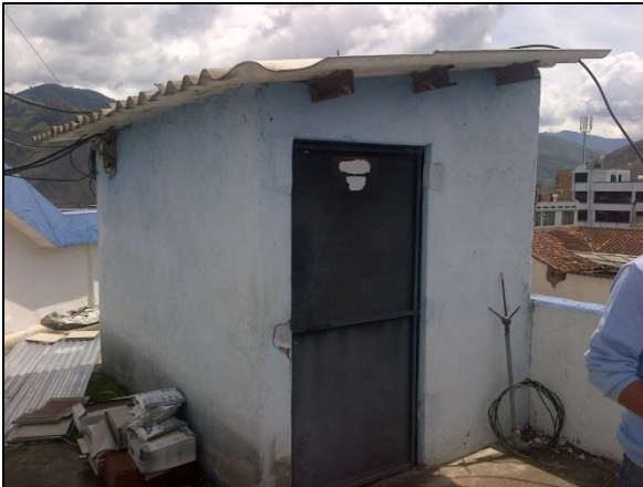
Figura 4. Bodega en la terraza del Edificio Municipal
