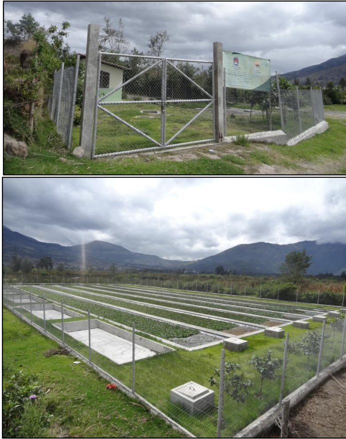
Figura 3.1 Planta de Tratamiento de Aguas Residuales Huaycopungo Norte
