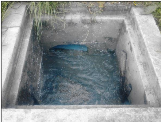
Figura 3.2 Afluente Agua Residual Cruda
