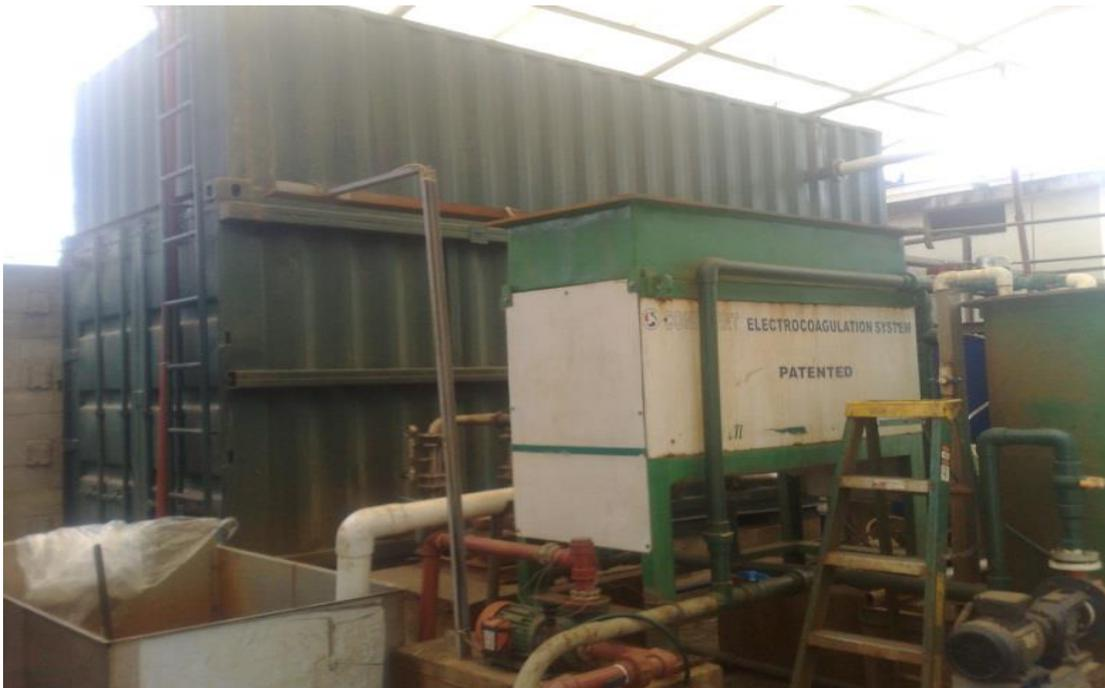
Gráfico 6. **Planta de tratamiento mediante electrocoagulación**
