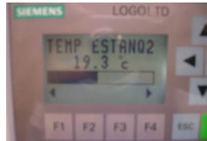
Figura 17 Temperatura actual estanque 2
