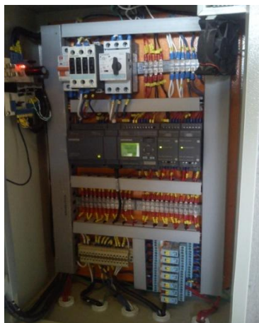
Figura 36: Sistema automático de riego y fertirrigación
