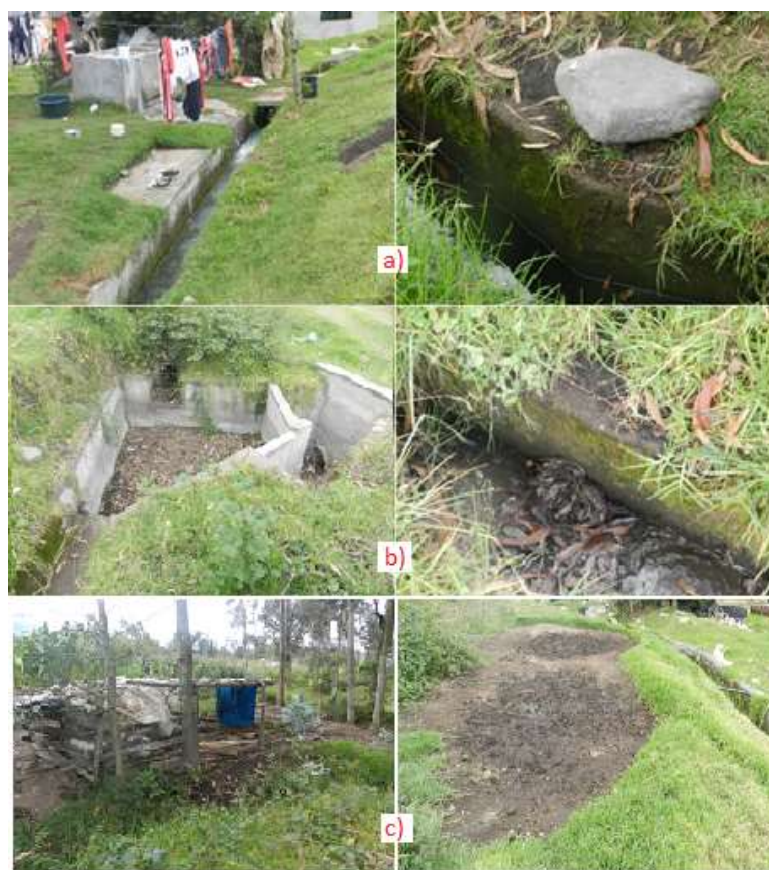
Figura 4. 23: Conflictos dentro del canal de riego, debido a contaminación por desechos sólidos y líquidos. a) contaminación con detergentes, b) eliminación desechos c) actividades pecuaria.
