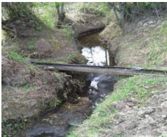
Fotografía 16. Cruce de agua acequia Carayaku
