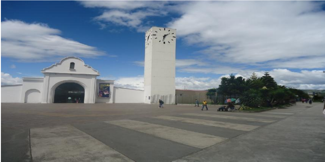
Ingreso principal del terminal terrestre de la ciudad de Ibarra.
