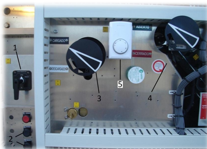
Gráfico N° 18 Interruptor en local y abierto
