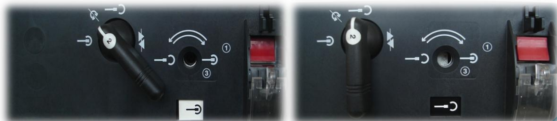
Gráfico N° 34 Posición de la manija para extraer el interruptor
