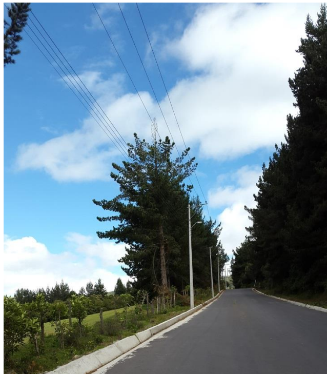
Figura 113. Postería vía a la Zona de Intag
