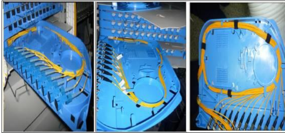
Figura 60. Organización de patchcords dentro de las bandejas de los ODF
