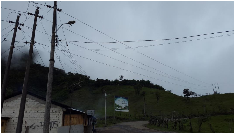
Figura 115. Postería de media Tensión hacia Apuela.
