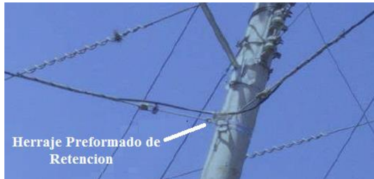
Figura 126. Herraje Preformado de retención
