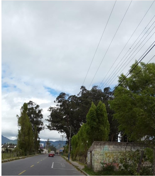
Figura 112. Postería Vía a Cuicocha
