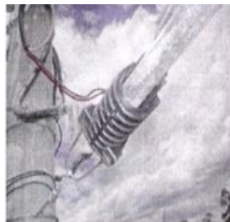
Figura 130. Tensor de Fibra óptica.
