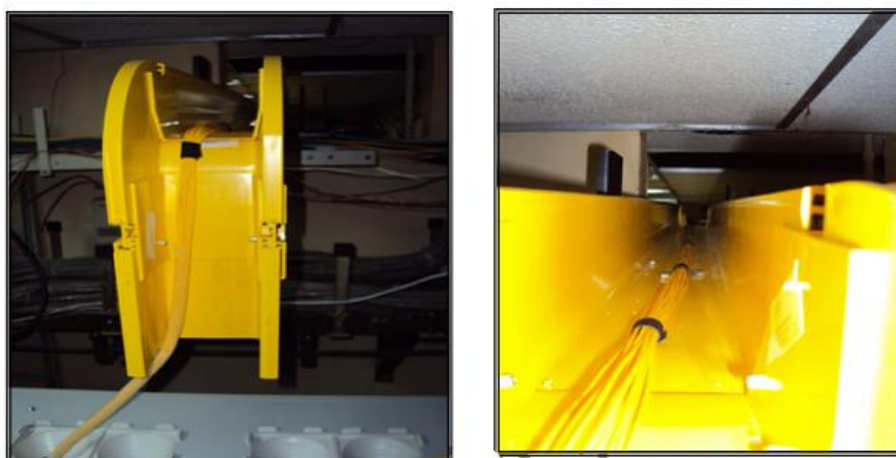
Figura 57. Instalación de Patchcords utilizando fiber runner
