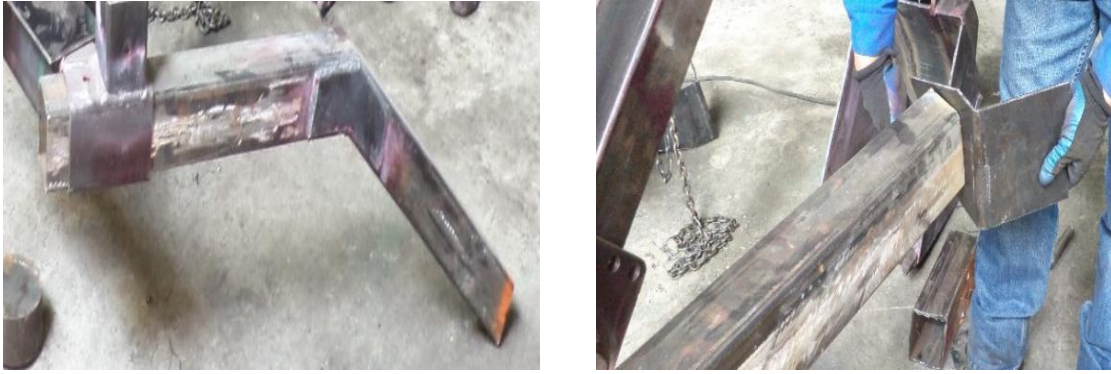
Figura 63. Construcción patas de anclaje.
