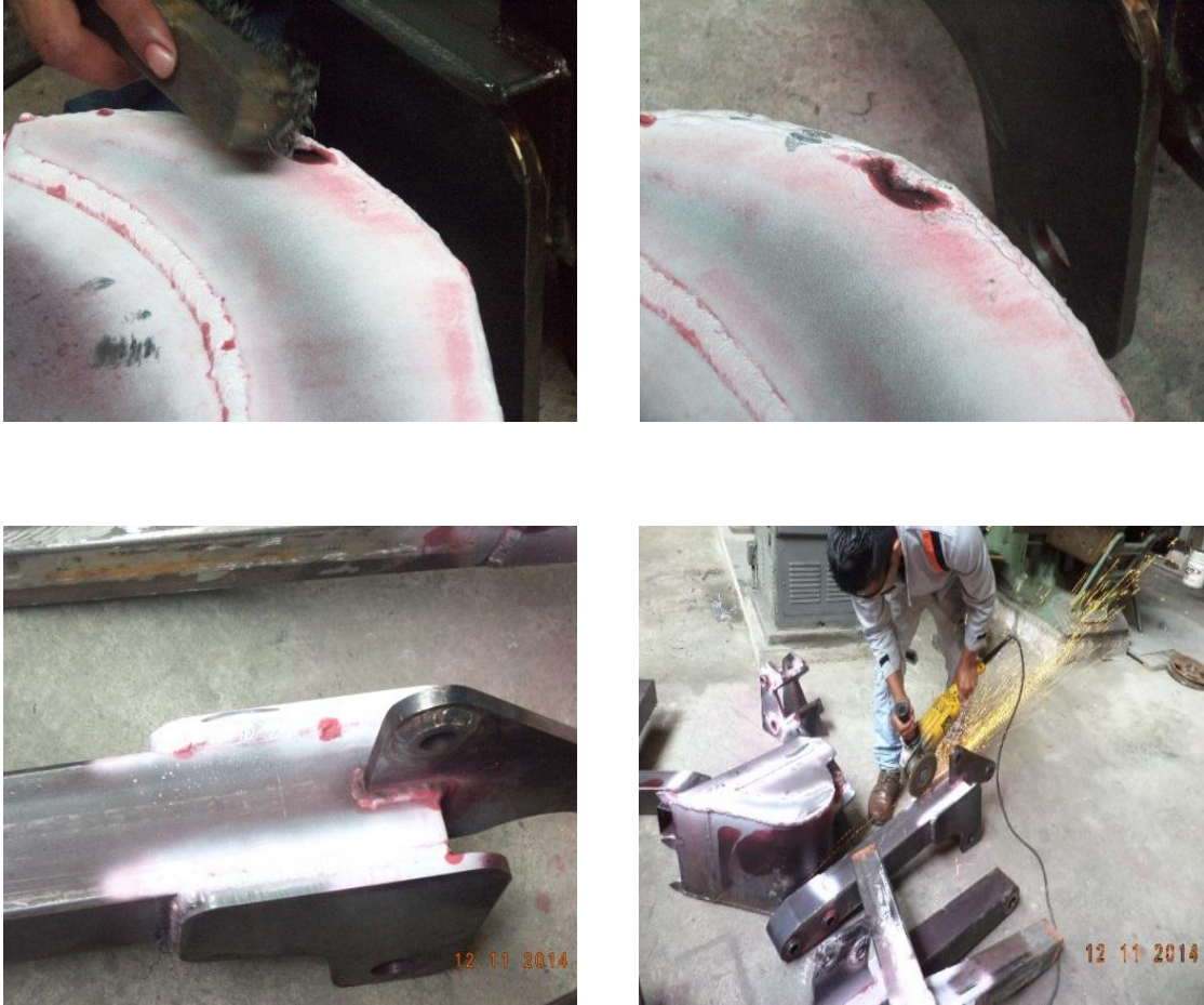
Figura 71. Inspección y corrección de fallas.
