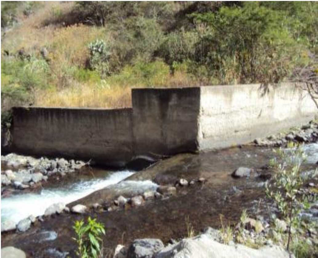
FOTOGRAFÍA 5 MURO DEL BOCATOMA
