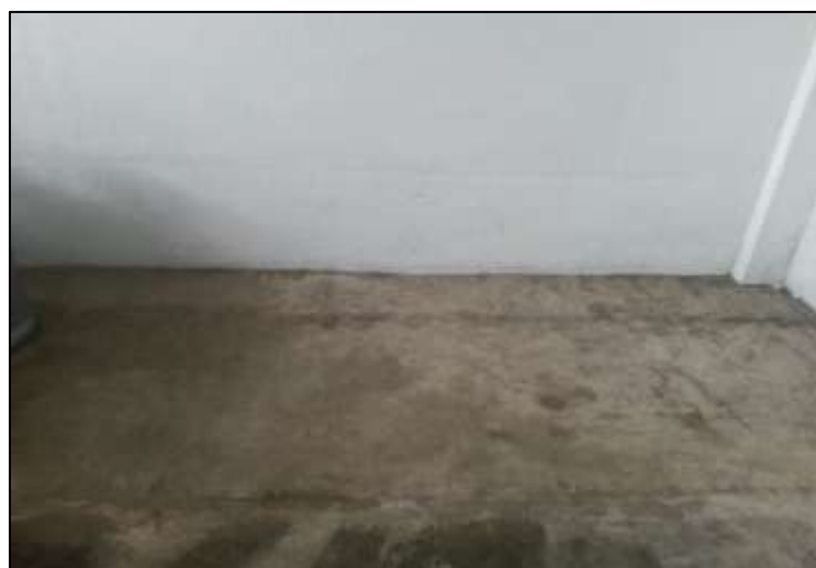
FIGURA 6.13: Retirado el tanque de almacenamiento de agua reciclada
