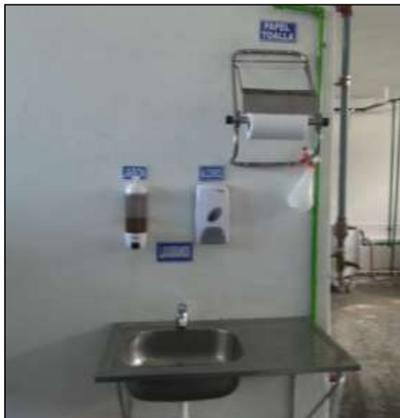
FIGURA 6.3: Implementación de lavamanos dentro del área de producción
