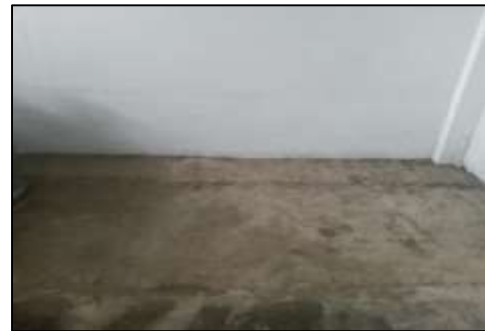
Figura 16. Retirado el tanque de almacenamiento de agua reciclada
