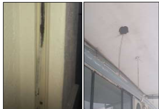
Figura 17. Instalaciones eléctricas antes de la implementación
