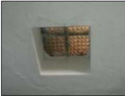
Figura 13. El techo antes de cubrir las ventanillas que tenía
