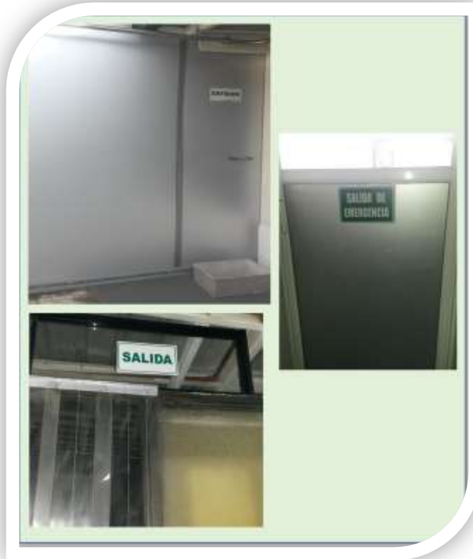
FIGURA 6-9: Accesos a la Planta de Producción
