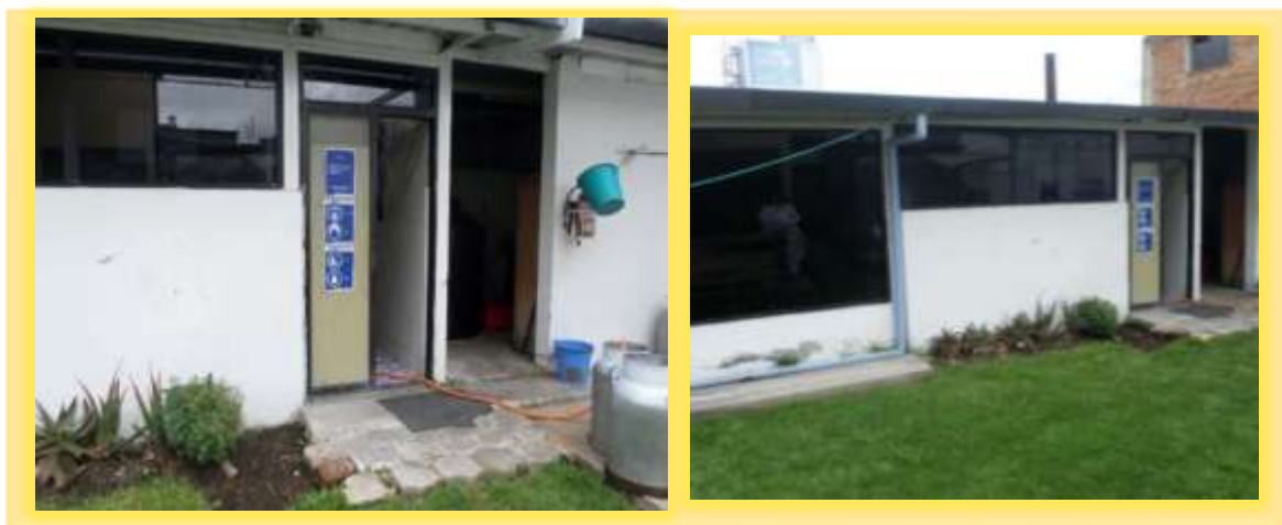
FIGURA 3-7: Situación Inicial de las Instalaciones UNIQUESO
