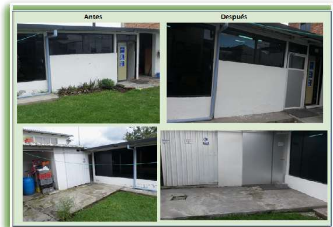
FIGURA 6-7: Exteriores de la Planta
