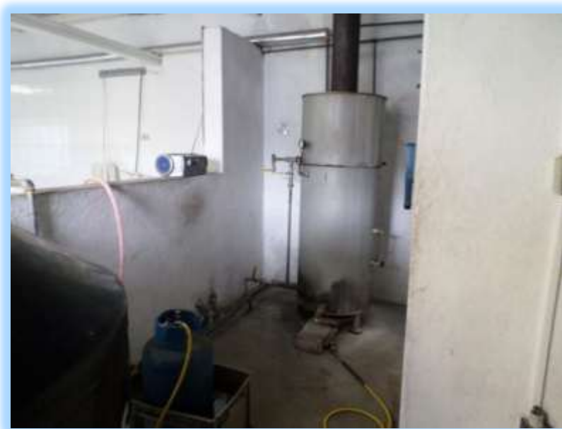
FIGURA 3-6: Situación Inicial de las Instalaciones UNIQUESO
