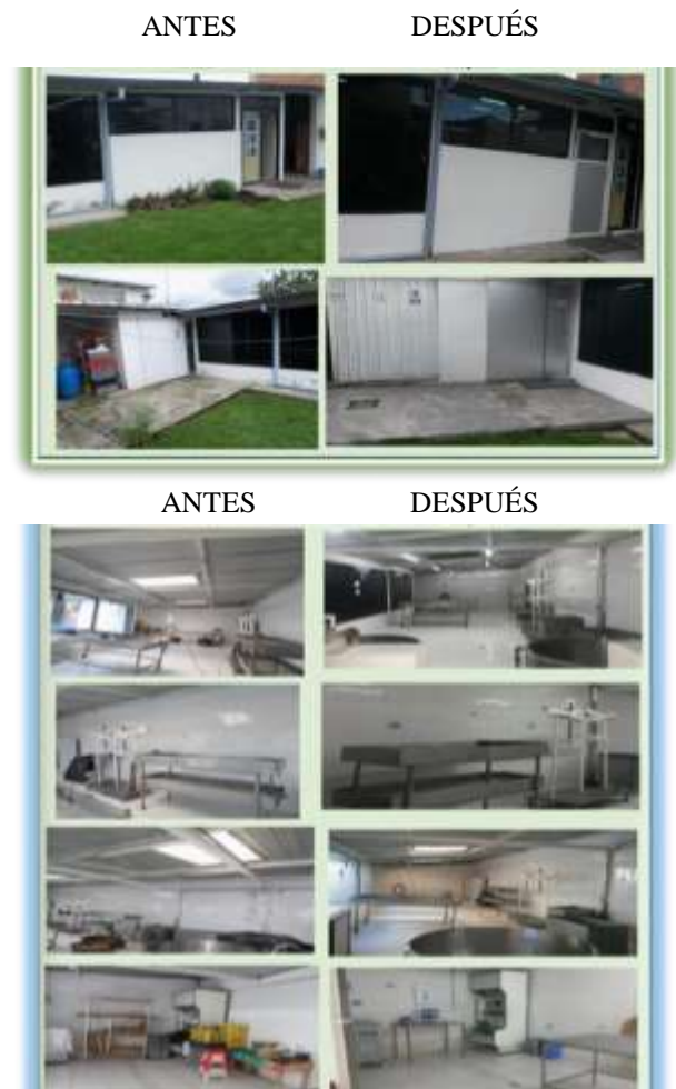
Figura. 2. Adecuaciones de Infraestructura en Uniqueso
