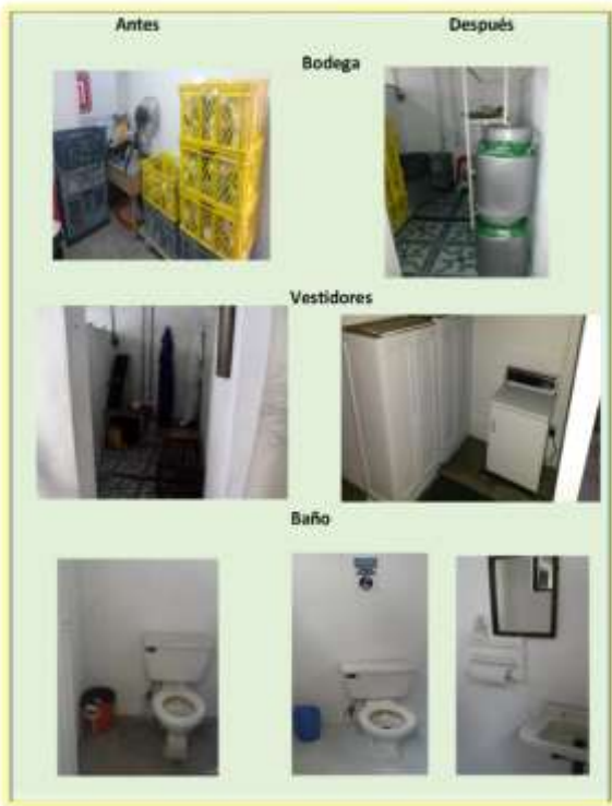
Figura. 3. Adecuaciones de Infraestructura en áreas complementarias en Uniqueso
