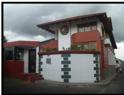
Figura 6. Edificio FLORALP S.A. Matriz Ibarra. Referencia: FLORALP S.A. Recuperado de: http://www.worldtravelserver.com
