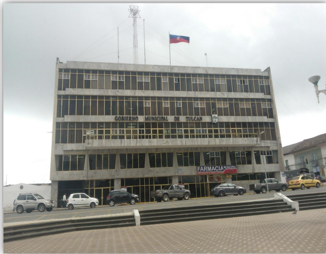
Figura 31: Vista frontal del edificio GAD-MT
