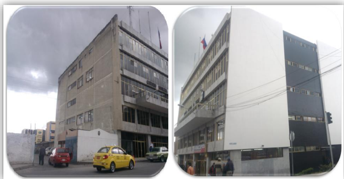
Figura 32: Vista lateral del edificio GAD-MT
