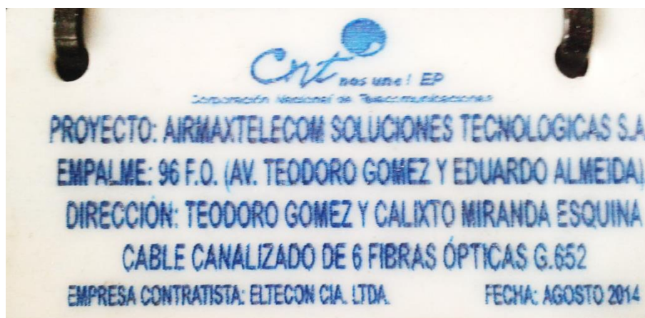
Figura 20: Identificadores. Enlace de Fibra Proyecto AIRMAXTELECOM S.A.
