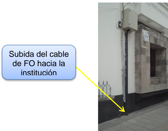
Figura 68. Cambio de subterráneo a aéreo. Fuente: Calle Bolívar y García Moreno
