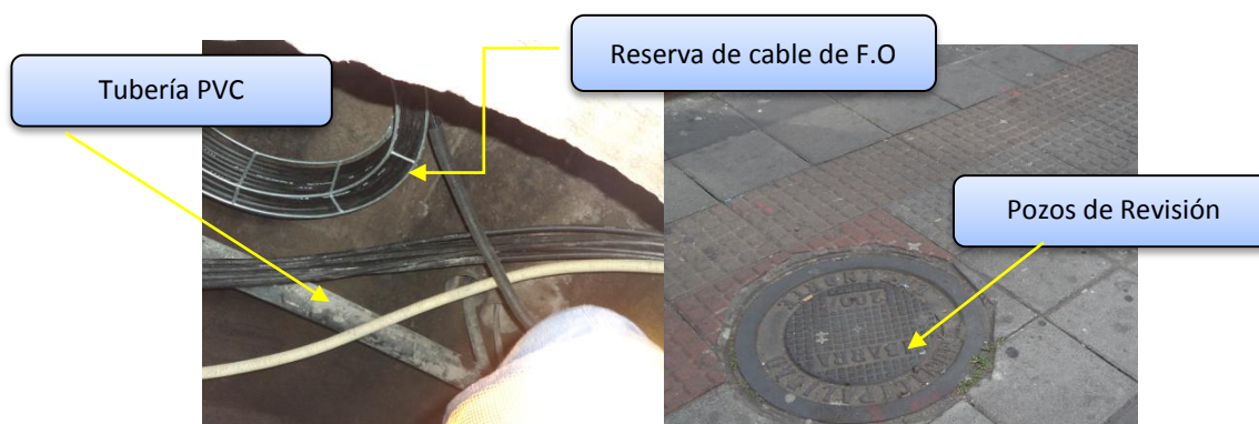
Figura 66. Pozos de revisión en el nodo de la Unidad de justicia.
