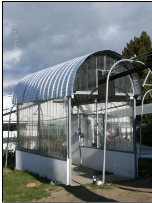
Figura 52: Túnel de fumigación electrostático Fuente: Autor
