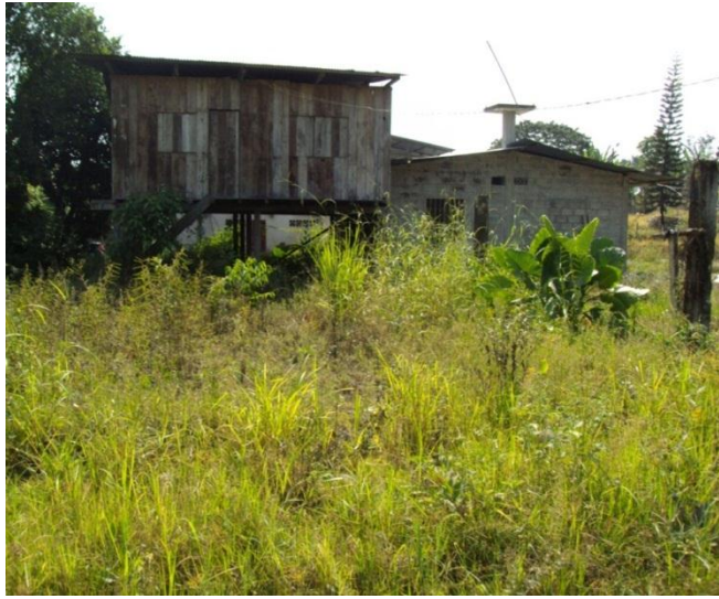
Vivienda de madera
