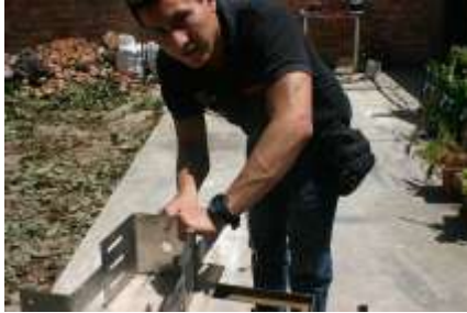
Lijando el soporte de las electroválvulas
