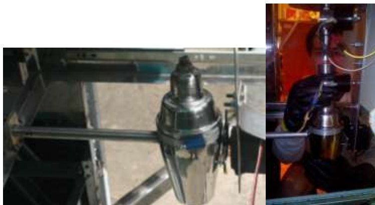
Figura 3. 35 Instalación del sistema de batido
