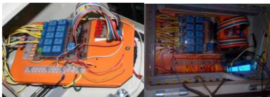
Figura 3. 32 Elaboración del tablero de control del sistema
