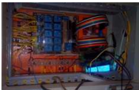
Figura 15 Montaje Tablero de Control
