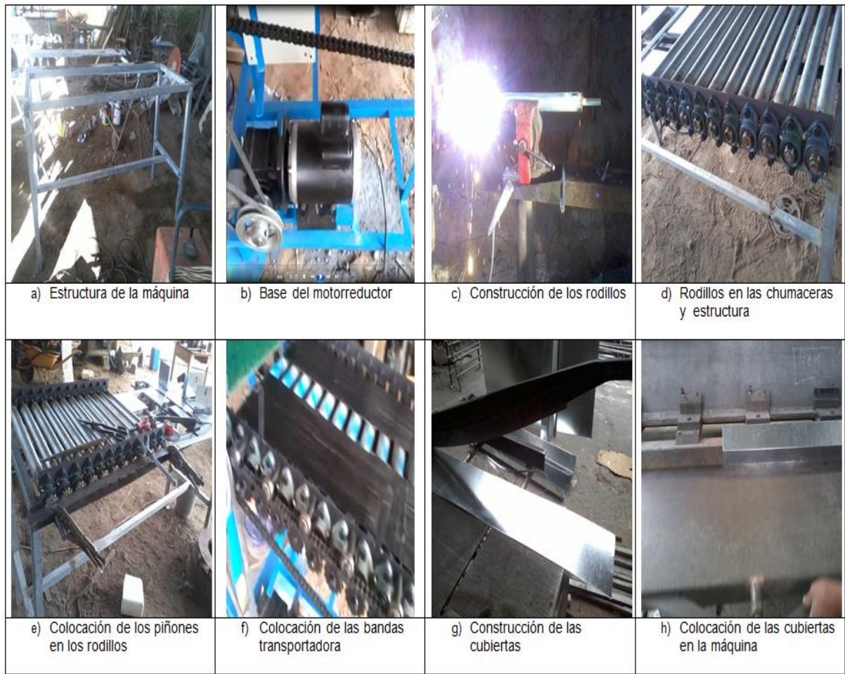
Figura 32.- Construcción del subsistema de Transporte y Ordenamiento
