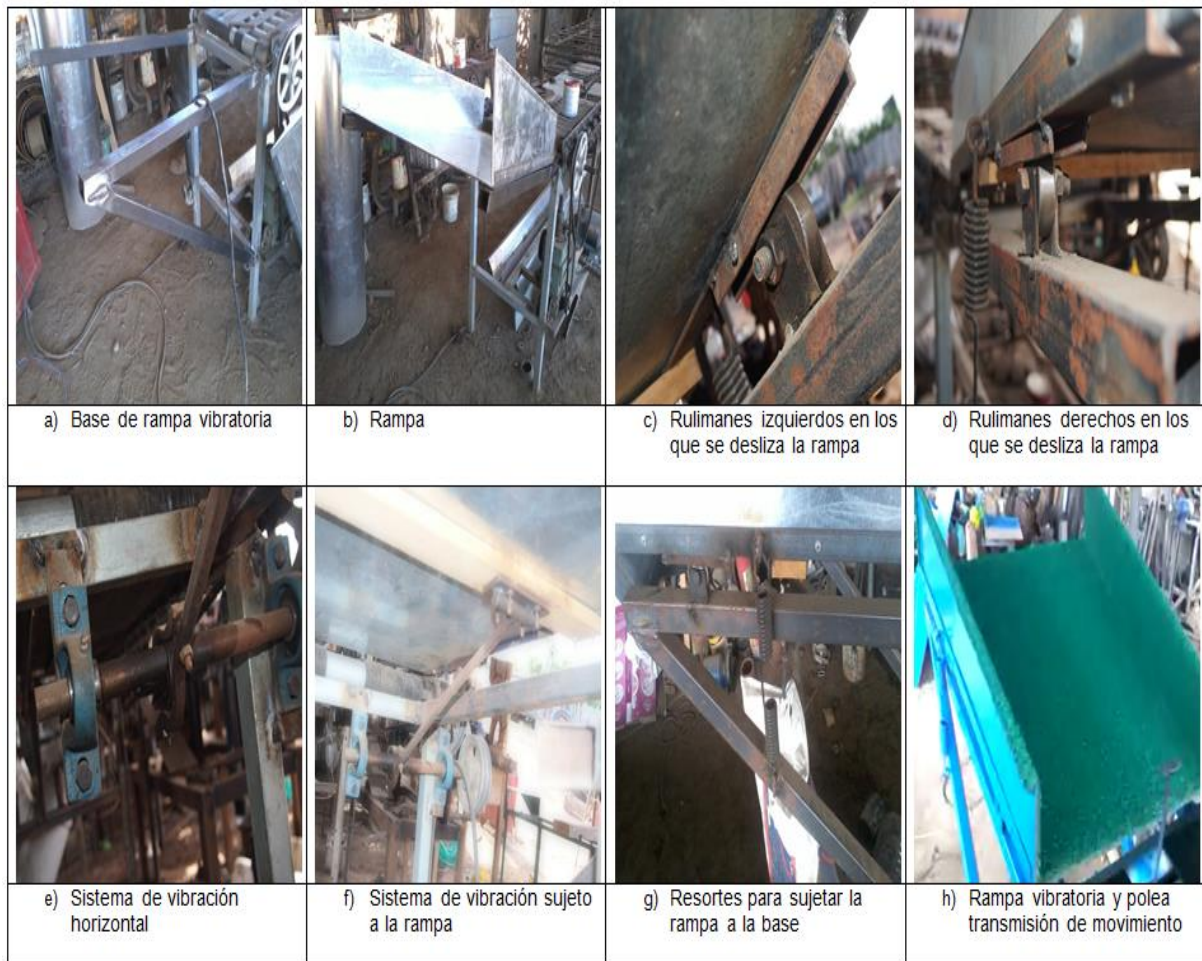
Figura 31.- Construcción subsistema de Alimentación
