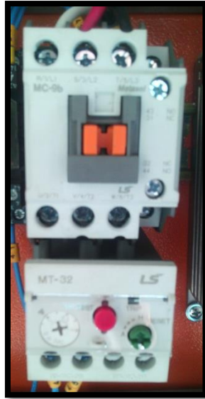
Figura 50. Ensamble de Contactor y relé térmico Fuente: Autor
