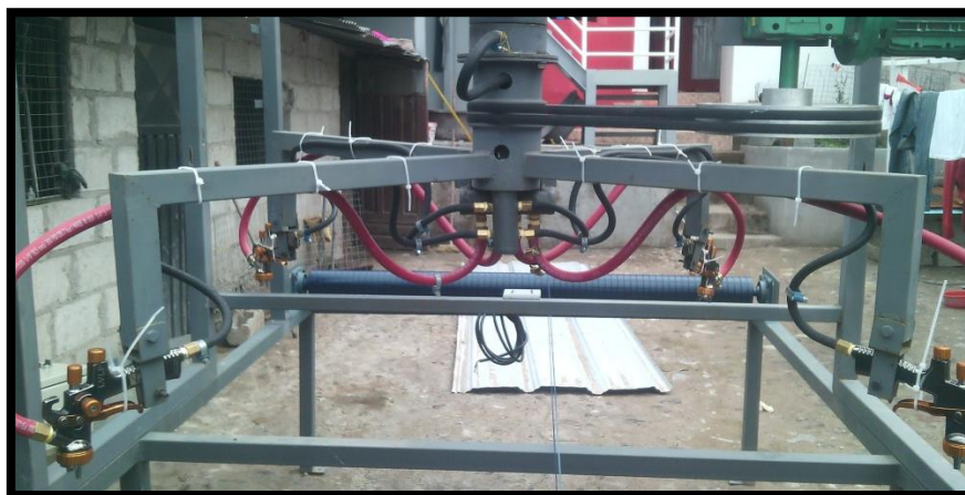
Figura 70. Manga de pintura instalada Fuente: Autor
