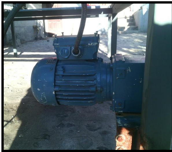
Figura 65. Instalación de motor trifásico de cinta Fuente: Autor
