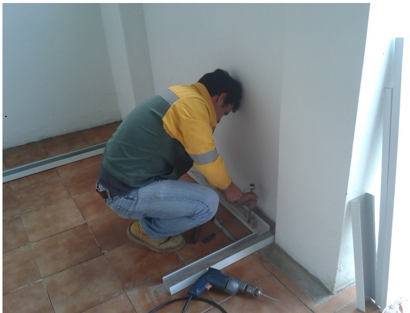
Figura 4.1 – Instalación de estructura angular
