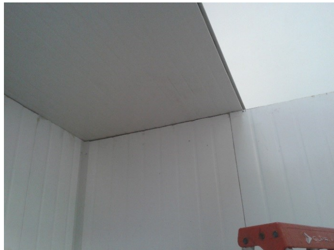
Figura 4.3 – Instalación de techo Elaborado: Guillermo Pacheco
