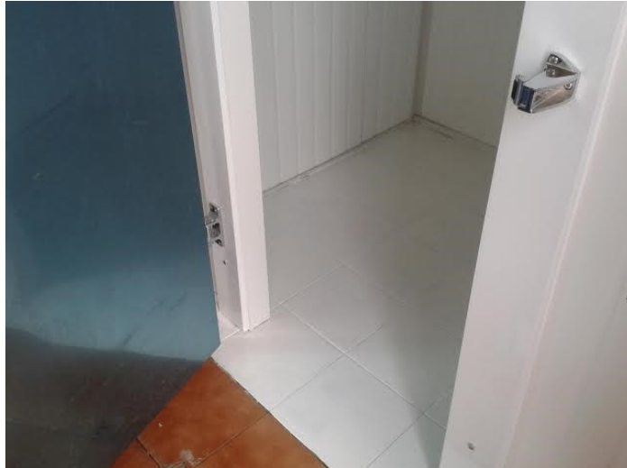
Figura 4.12 - Pintura de Piso
