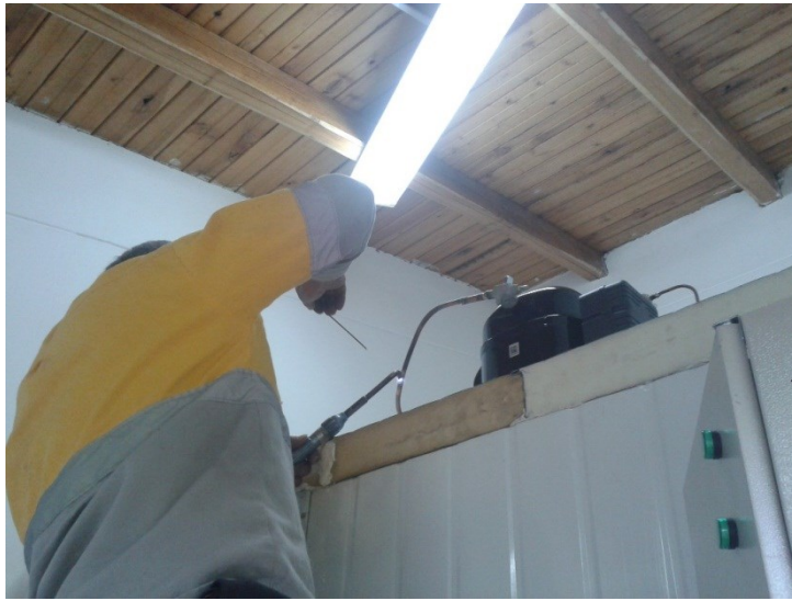
Figura 4.4 – Instalación de unidad condensadora
