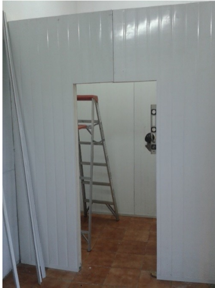
Figura 4.2 – Instalación de paneles Elaborado: Guillermo Pacheco
