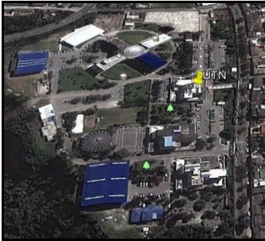
FIGURA 2-1: Vista satelital de la Estación Base en el Edificio Central de la UTN
