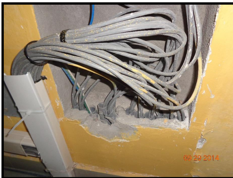
Figura 24. Canalización de los cables
