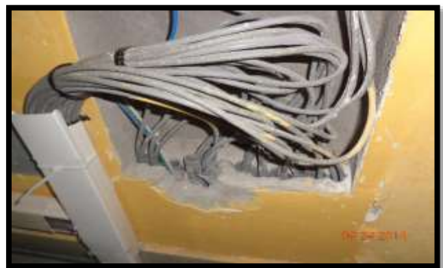
Figura 24. Canalización de los cables
