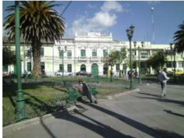
Figura 9. Edificio principal del GADIPMC
