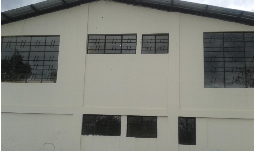
Figura 22. Estado de las ventanas después de realizar la instalación de la ventilación forzada.
