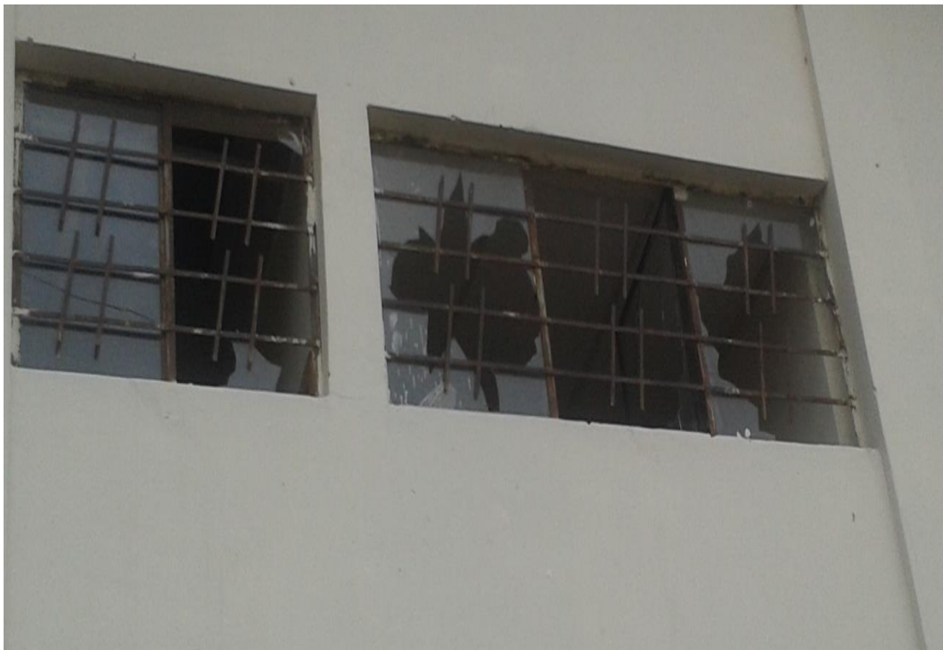
Figura 21. Estado de las ventanas antes de la instalación de la ventilación forzada.
