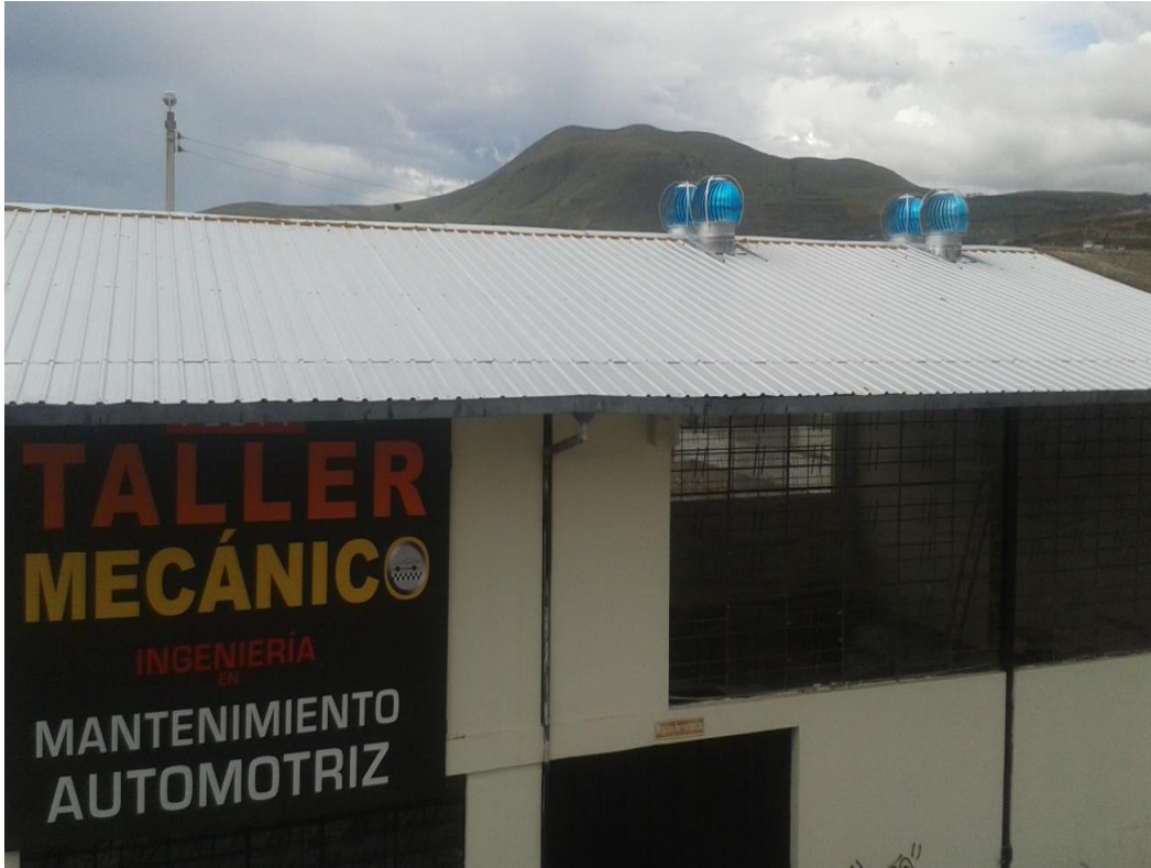
Figura 20. Vista principal del taller después de realizado el proyecto.
