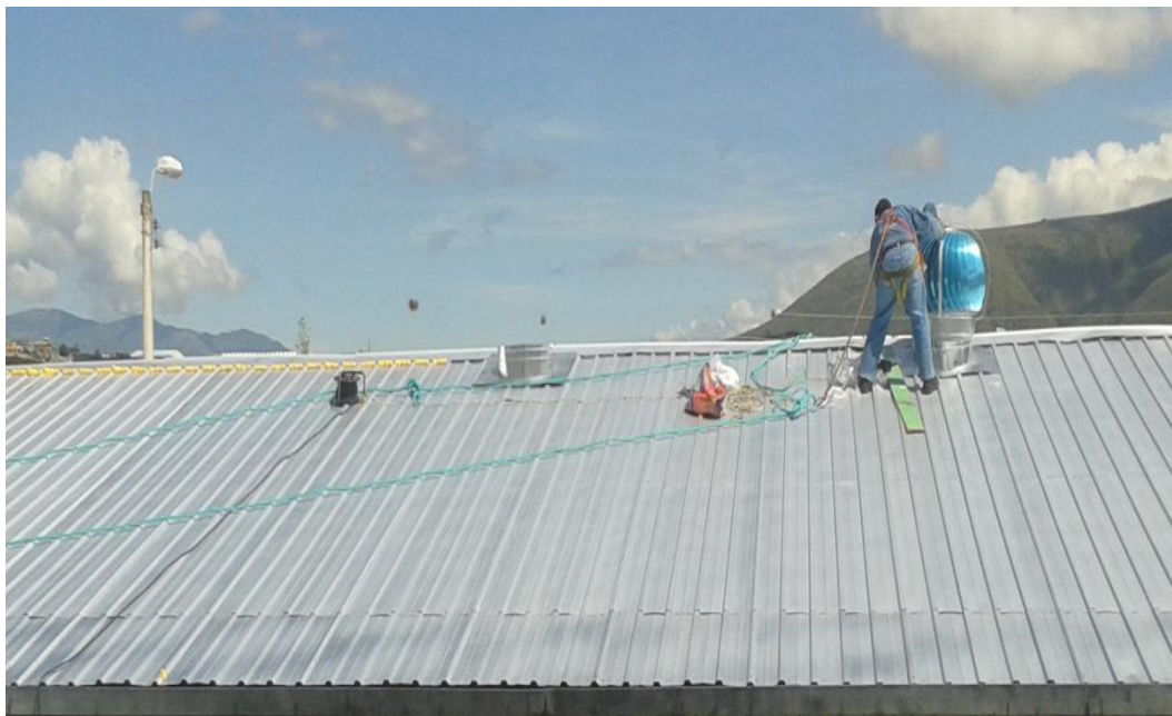
Figura 15. Instalación de los extractores en la cubierta del taller.
