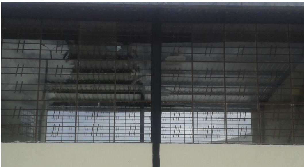
Figura 14. Ventanales con todos los vidrios colocados.
