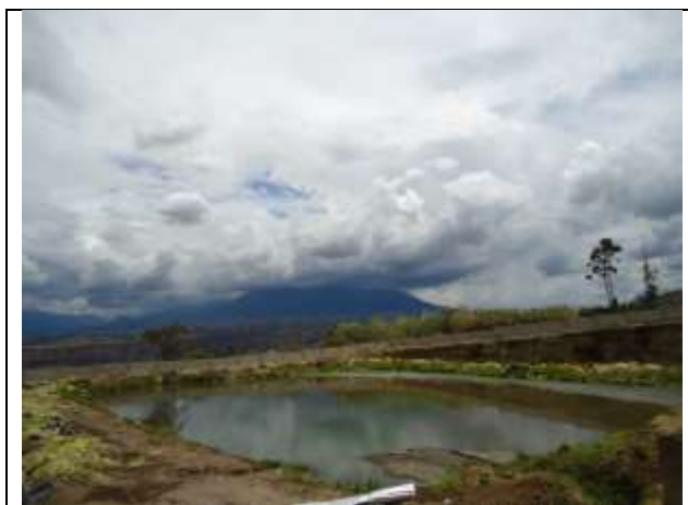
Fig. 4.17 Laguna de oxidación provisional
