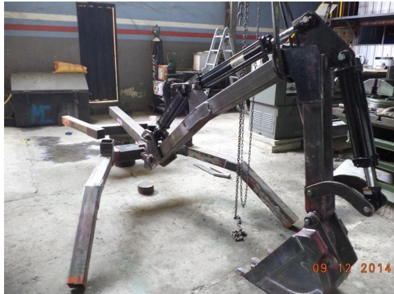
Montaje de los cilindros hidráulicos.
