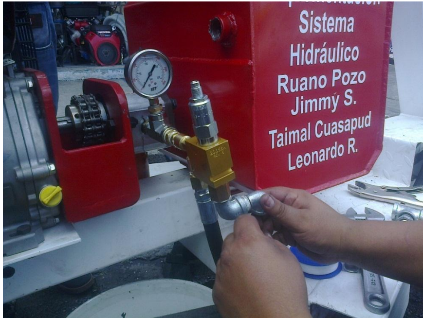
Instalación de la válvula de control de presión.
