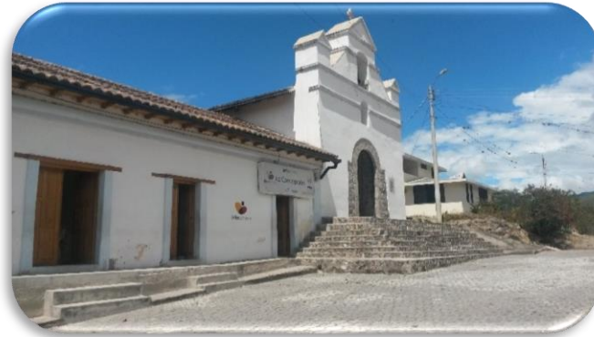
Imagen N° 6: Iglesia La Concepción Fuente: Propia
