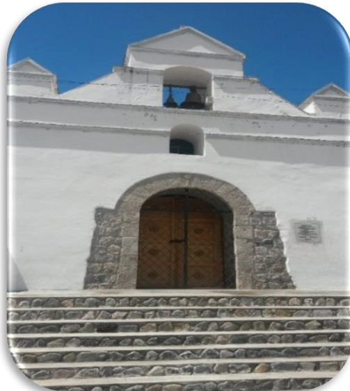
Imagen N° 8: Iglesia La Concepción Fuente: Propia
