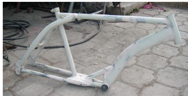
Figura 37. Construcción del cuadro
