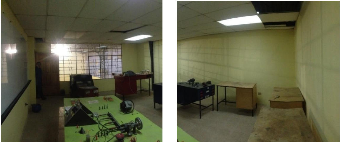
Figura 72: Estado de aula para la adecuación del Laboratorio de Metrología.
