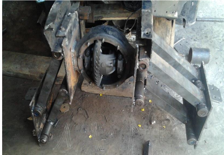
Figura 53: Montaje estructura sistema independiente.
