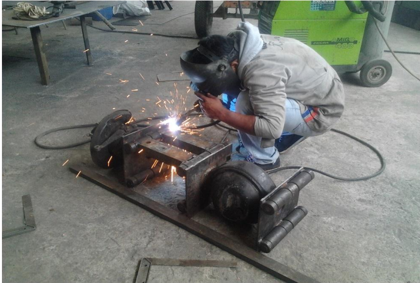
Figura 47: Montaje y soldadura de perfiles UPN.
