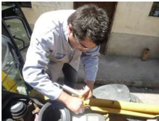
Figura 3. Acoplando la manguera a la bomba de vacío.
