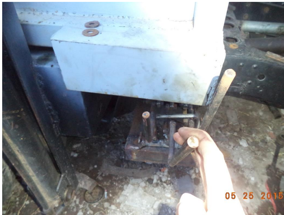
Instalación válvulas de control
