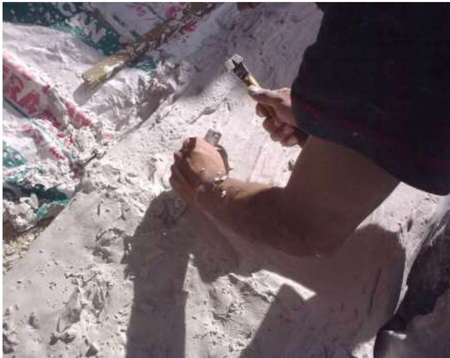
Fotografía N°- 10: Proceso de desmolde
