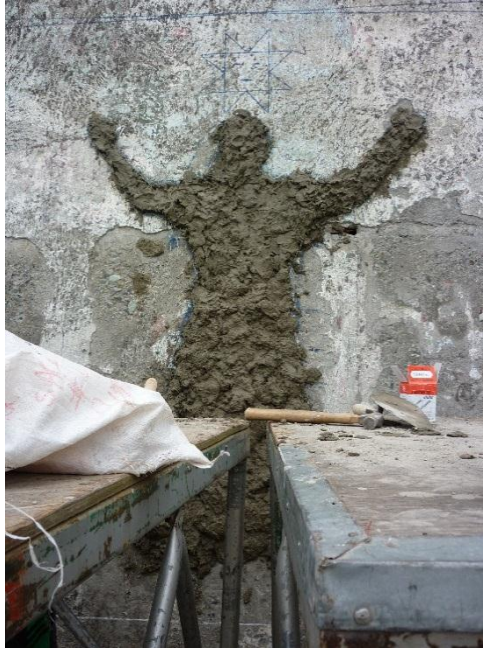
fig.6.25. Aplicación de cemento
