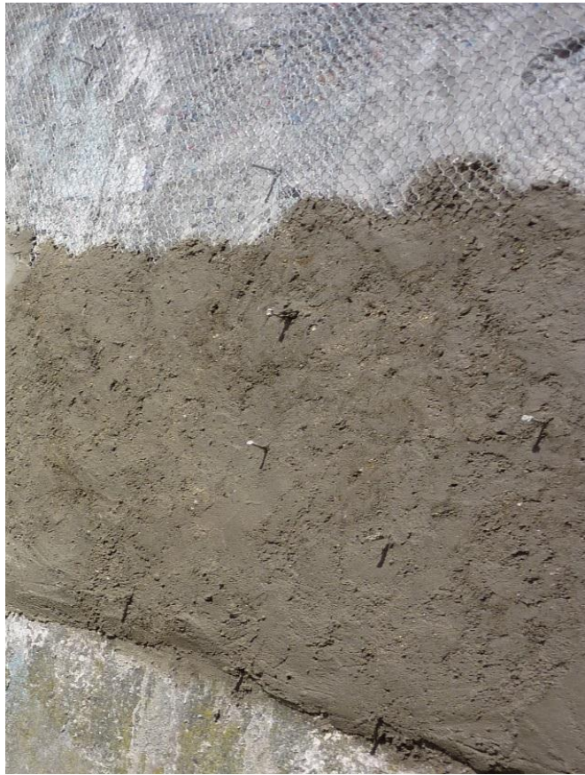
fig.6.24. Aplicación de cemento
