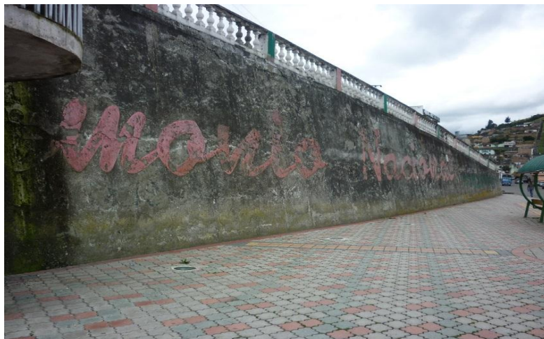
fig.6.21.Preparación de la pared
