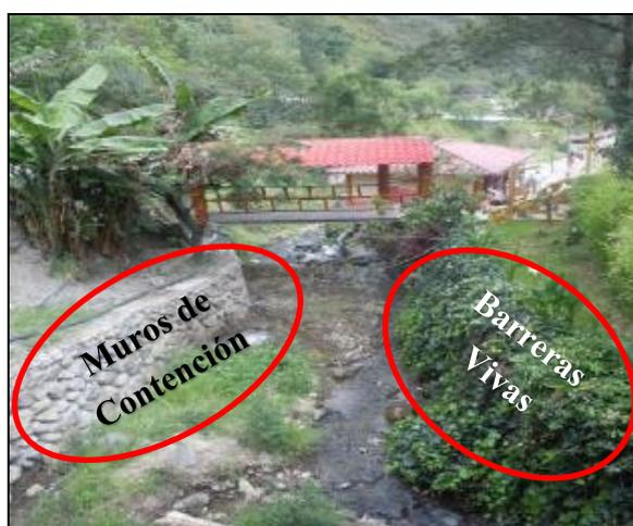
Figura 4-39: Manejo de Muros de contención y barreras vivas
