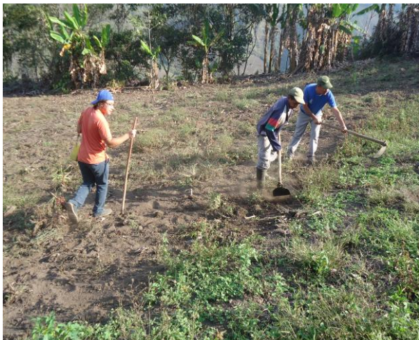
ANEXO 17. Limpieza del àrea
