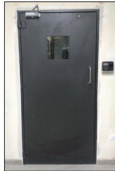
Figura 21. Puerta de Seguridad del Data Center Fuente: Proyecto de Diseño del Centro de Datos FICA
