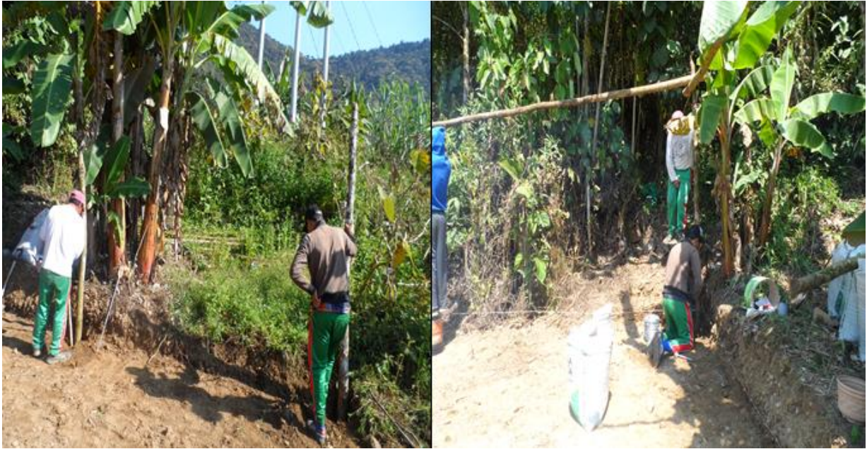
Fotografía 13. Colocación de pingos.
