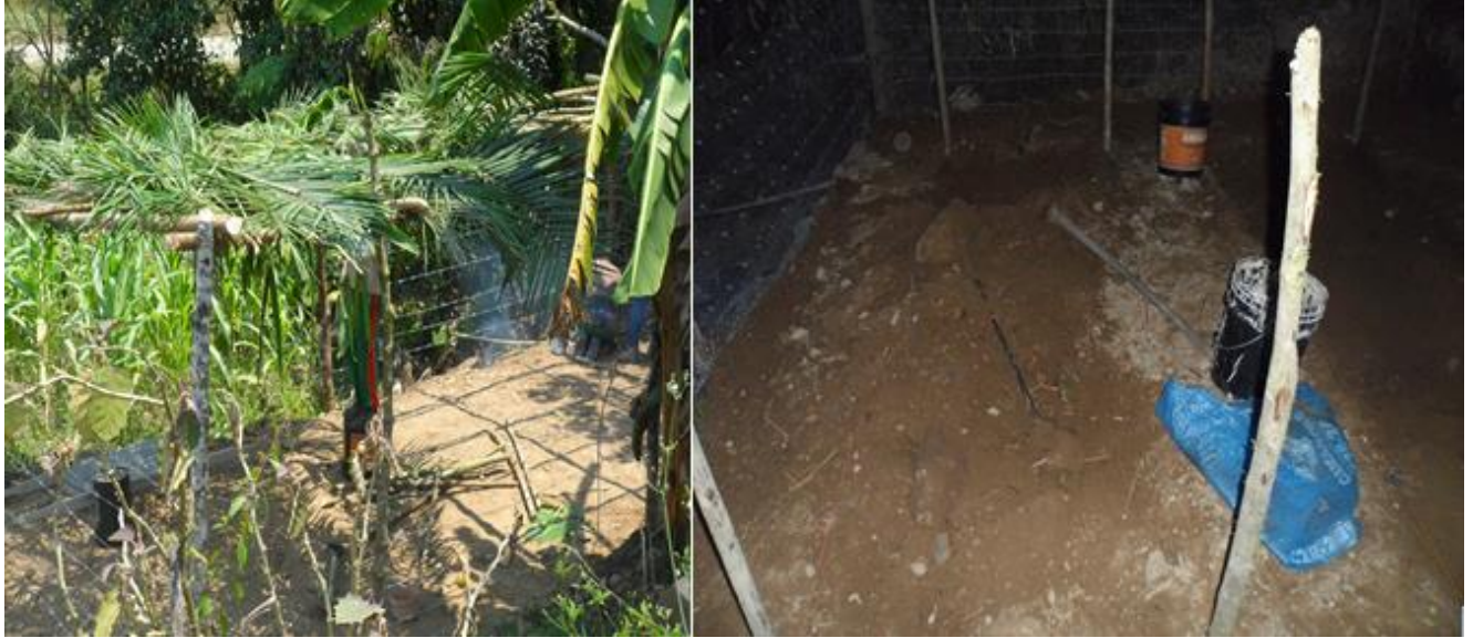
Fotografía 15. Colocación de cubierta y construcción de platabandas.
