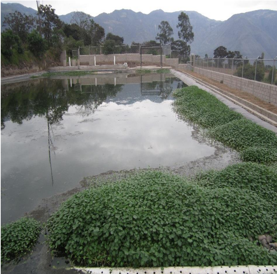
Figura 3.4 Fotografía de la planta de tratamiento de agua residual Cahuasqui
