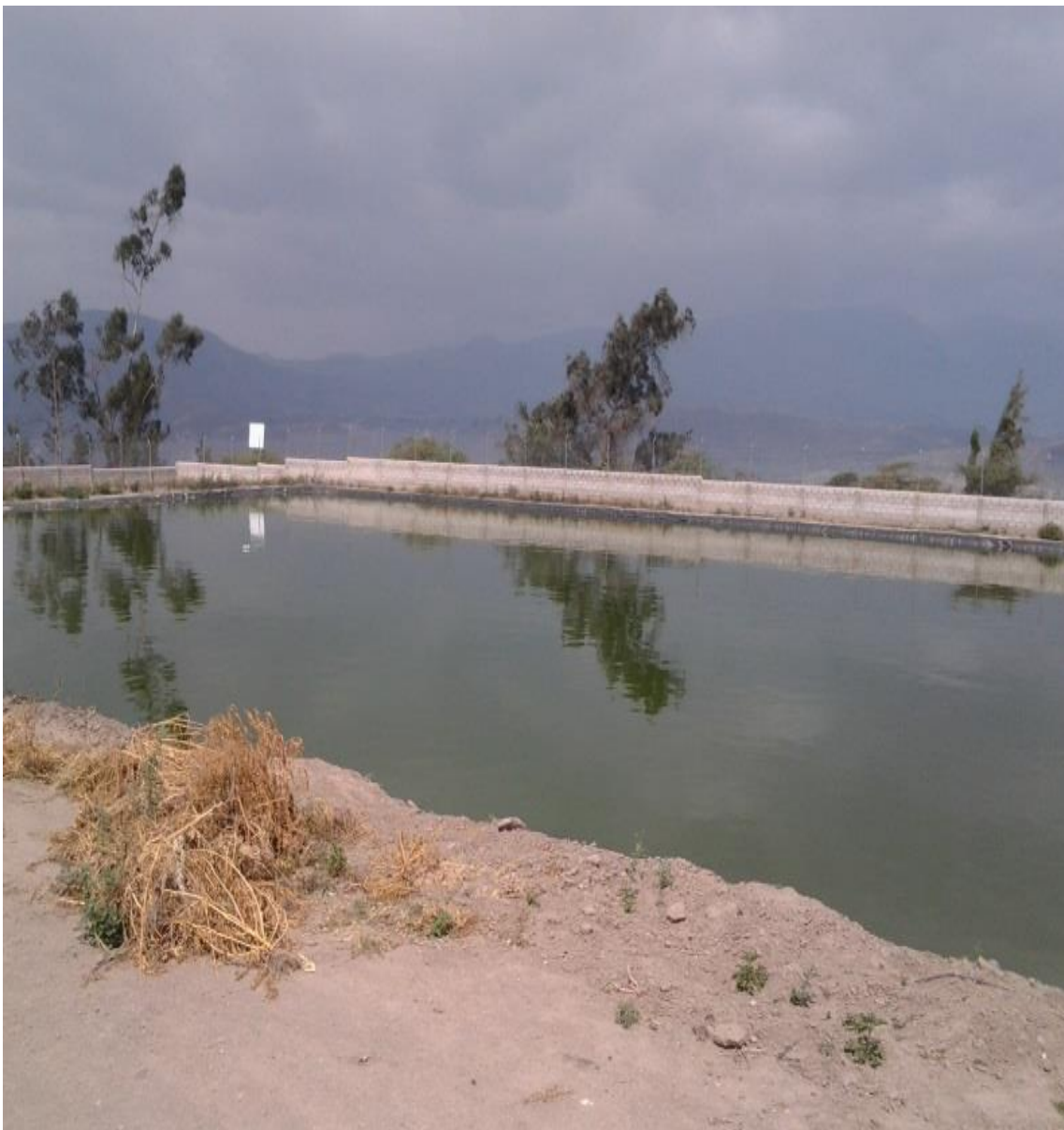
Figura 3.5 Fotografía de la planta de tratamiento de agua residual Las Marías Urcuquí
