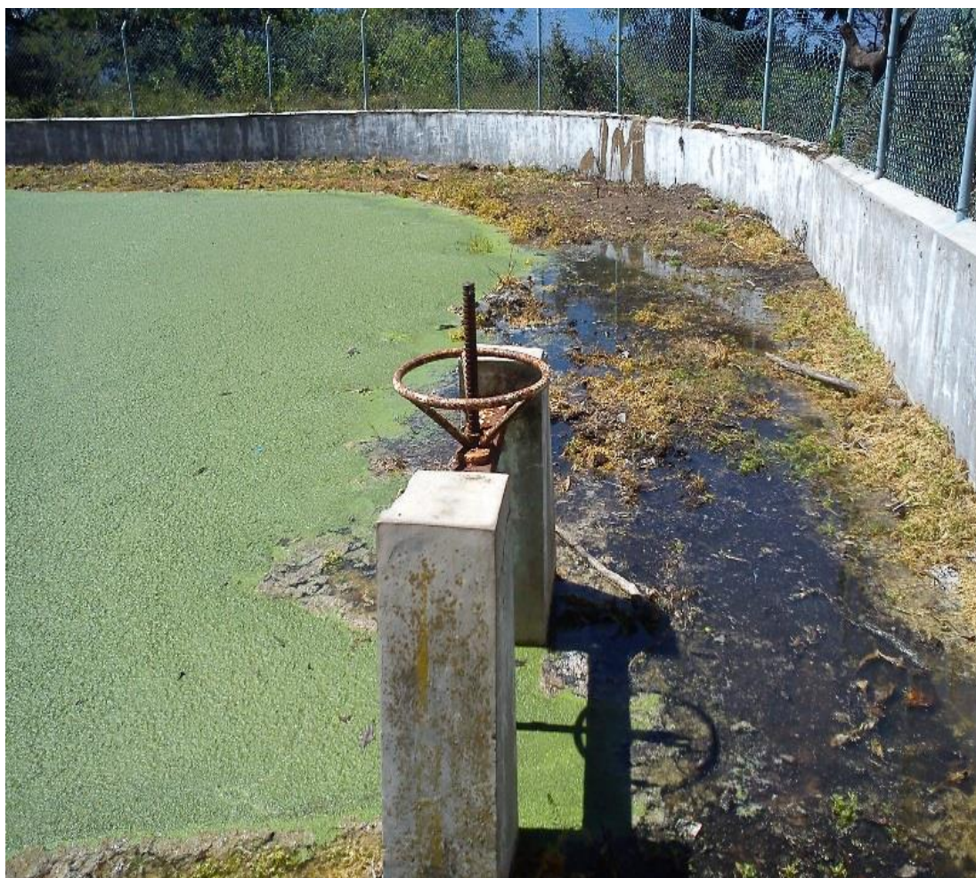
Figura 3.3 Fotografía de la laguna de oxidación Pablo Arenas
