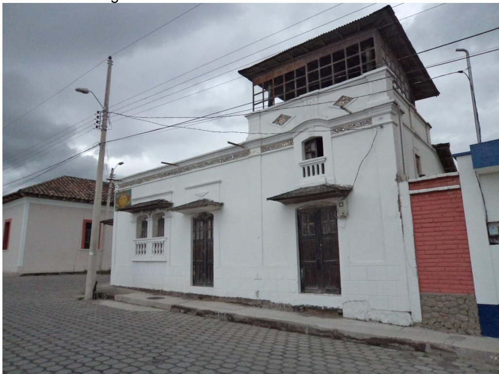
Figura N° 31. Foto lateral de la Casa Cultural
