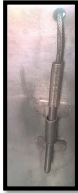
Figura 3.51 Colocación del sensor de temperatura
