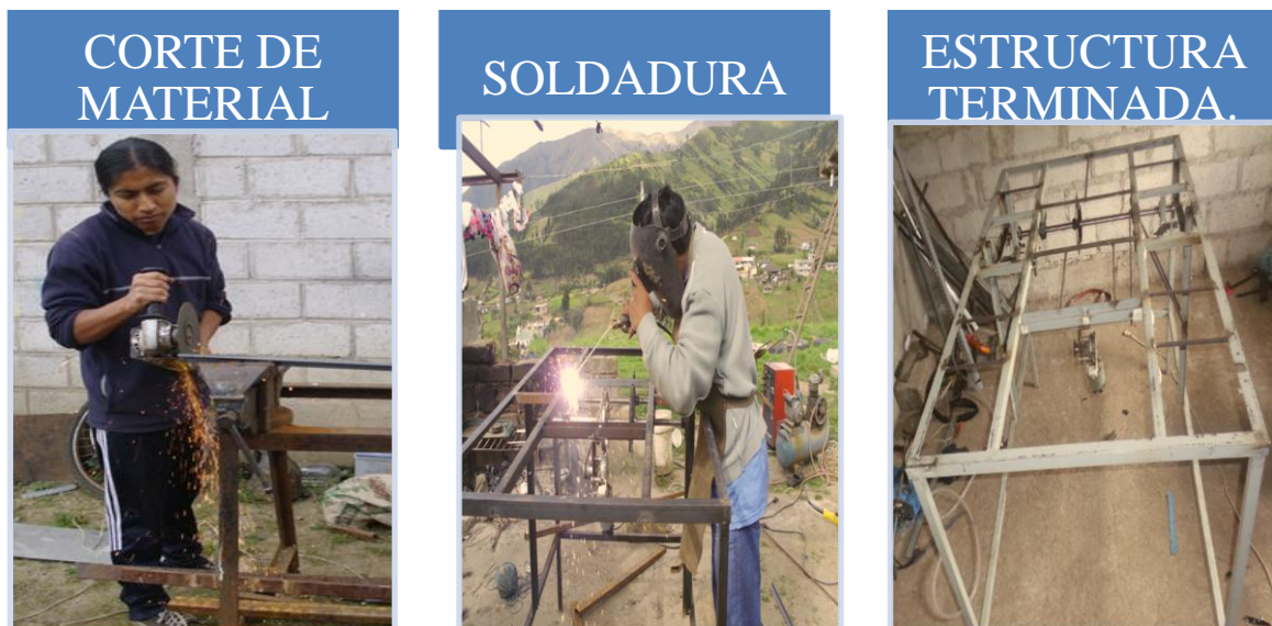
Figura 4.2: Proceso de fabricación de la estructura de la máquina.
