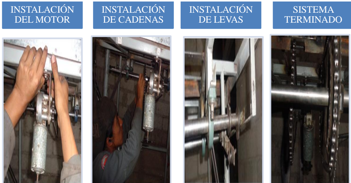
Figura 4.8: Proceso de instalación del sistema de transmisión.
